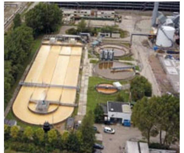
De afvalwaterzuiveringsinstallatie van Huntsman wordt nu beheerd door Evides
